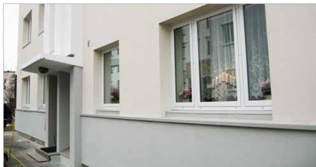
Etterisolerte fasader med Sundolitt EPS, Boligblokk i Ålesund
